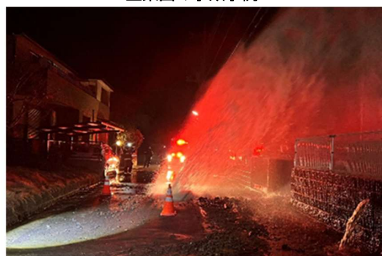
昭和60年頃布設の配水管が経年劣化のため破損(R7.2.11) 21世帯が断水（約6時間 2:50～9:20）
