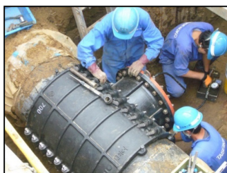
場内連絡管更新工事
