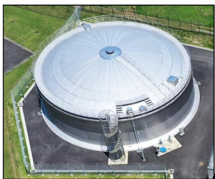
松尾配水場3号配水池
