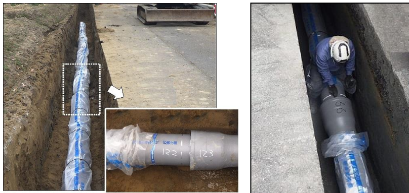
基幹管路耐震化工事
