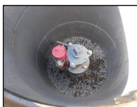
排水栓点検調査
