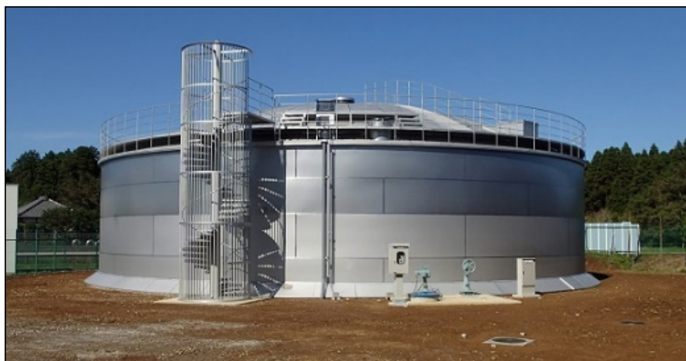
松尾配水場 3号配水池（令和元年10月築造）
