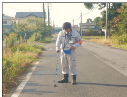
漏水調査（音聴検査）
