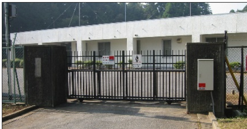
成東配水場（令和4年3月廃止）
