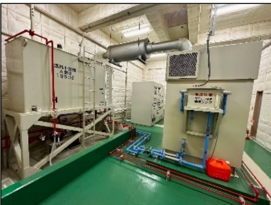
松尾配水場（令和 4 年度更新）
