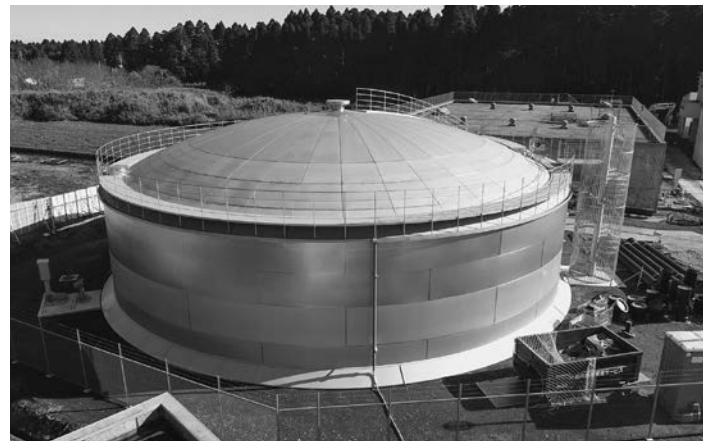
令和元年 松尾配水場3号配水池完成
