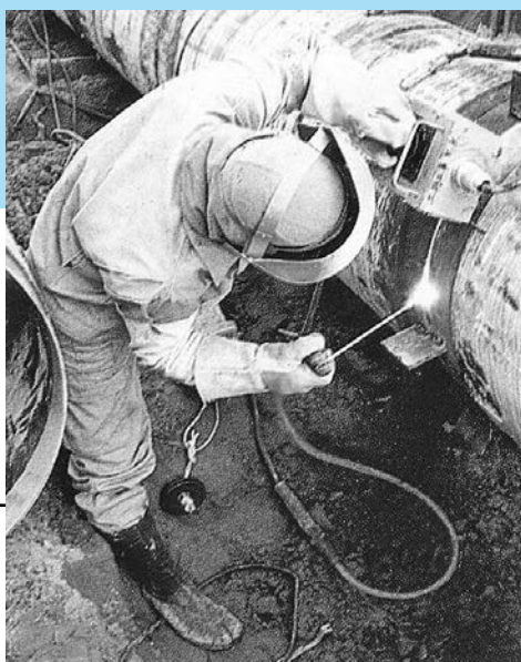
配水管整備事業
