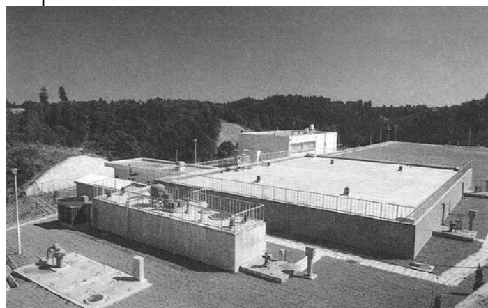
昭和51年 東金配水場1号配水池完成
