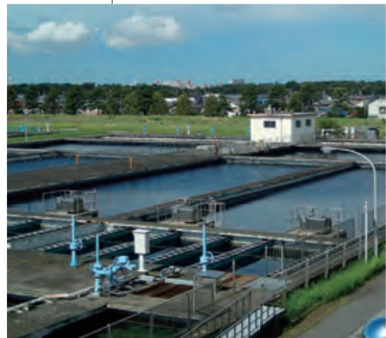
●沈でん池（柏井浄水場）
