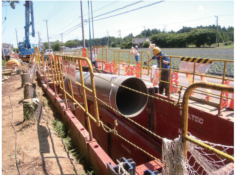
用水路（パイプライン）道路に管を埋める工事のようす
