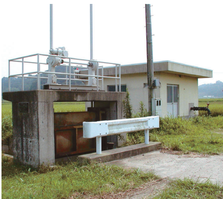
はんぷくきじょう 反復機場 一度使った水をもう一回使うための施設
