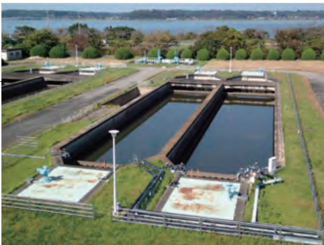
●取水場（印旛取水場）
