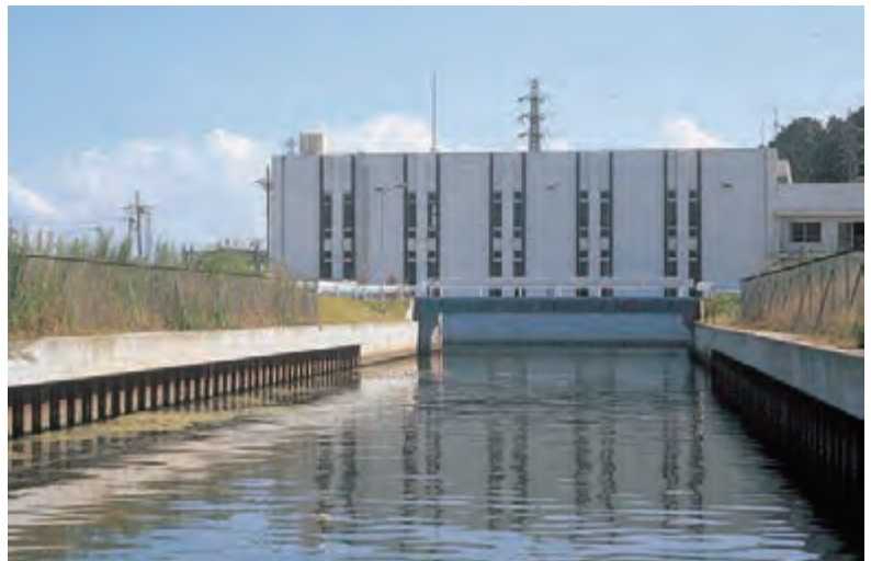
東庄町にある笹川揚水機場
