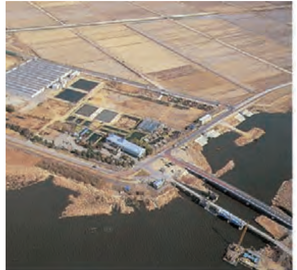
手賀川浄化施設
