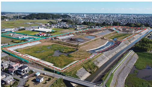
洪水時に一宮川の水を一時的に貯める調節池を増設しています(茂原市)
