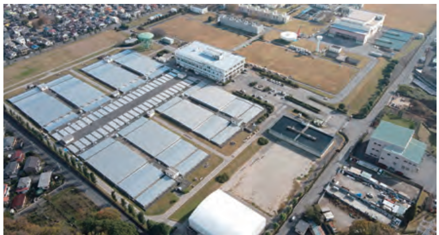
かしわい じょうすいじょう ●柏井浄水場 (千葉市、習志野市、船橋市、市川市、市原市の各市の一部及び浦安市全域に すいどうすい おく 水道水を送っています。)
