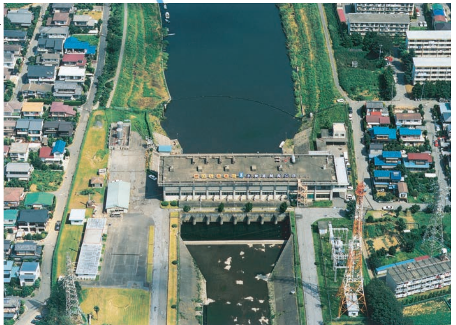
▲大和田機場(機場より上流 新川・下流 花見川)
