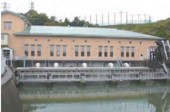
香取市にある両総第一揚水機場
