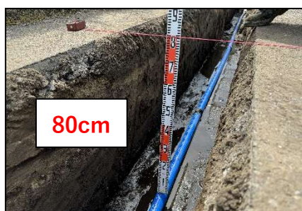
①⑨浅層埋設工法の適用
