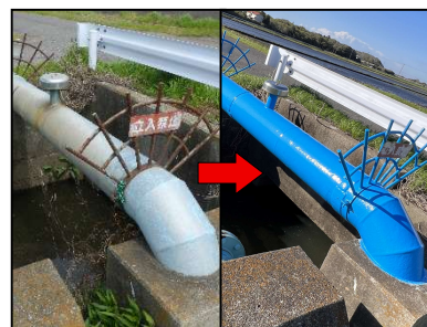
⑧水管橋補修塗装工事の様子
