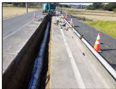
⑥重要給水施設配水管耐震化工事の様子
