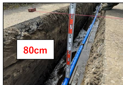
⑭浅層埋設工法の適用
