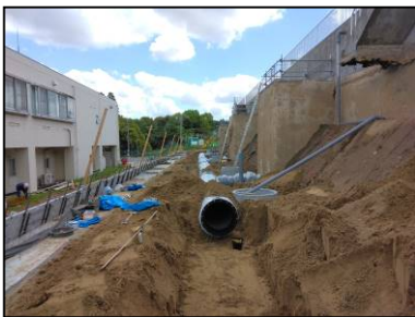
⑤東金配水場場内連絡管更新工事の様子
