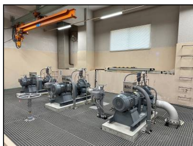
⑬東金配水場配水ポンプ設備更新
