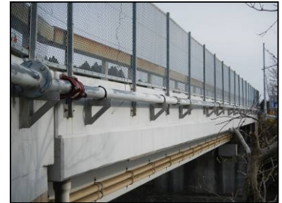
⑧点検した高速道路跨架橋
