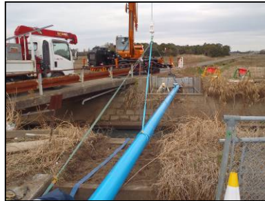
⑥重要給水施設配水管耐震化事業の様子（水管橋）
